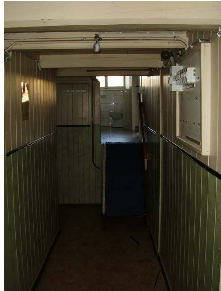
Absatz: links Treppe / rechts Tür
