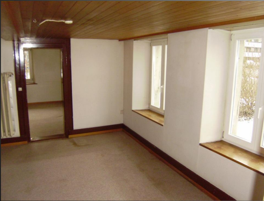
zur Nebenküche (Süden)
