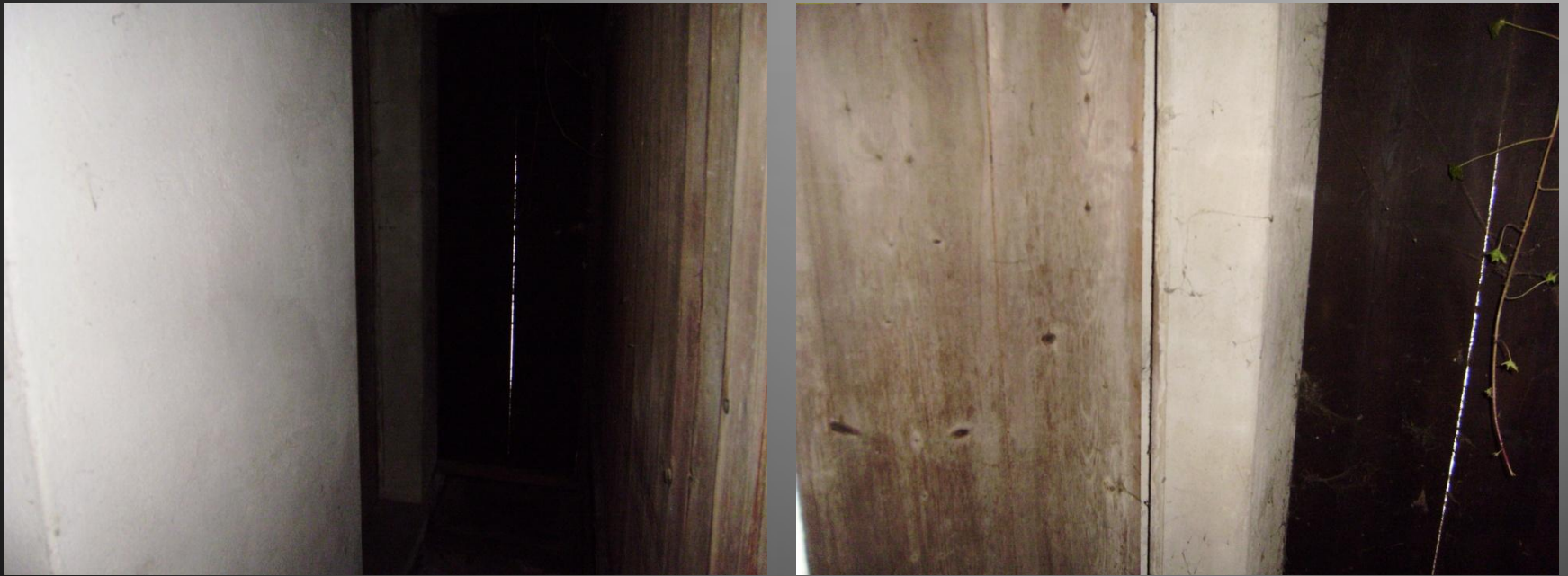
Anbau nach Osten
