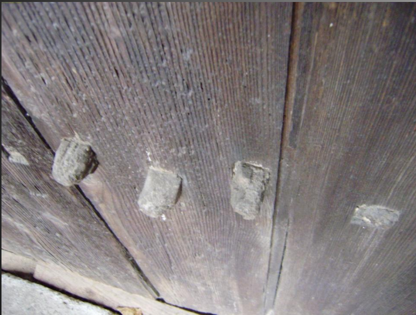
Alte Wand zum Tenn (Holzpropfen)
